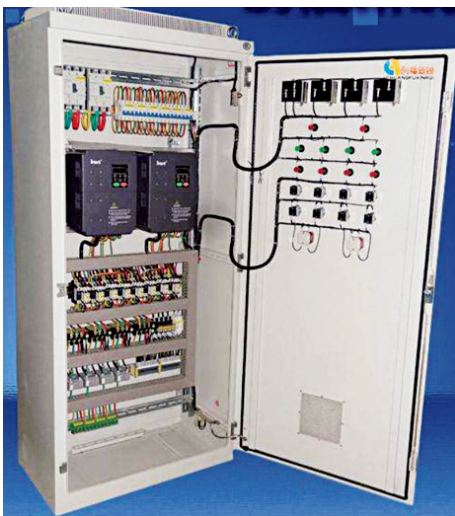
图1.6.4-2 风机水泵控制箱
